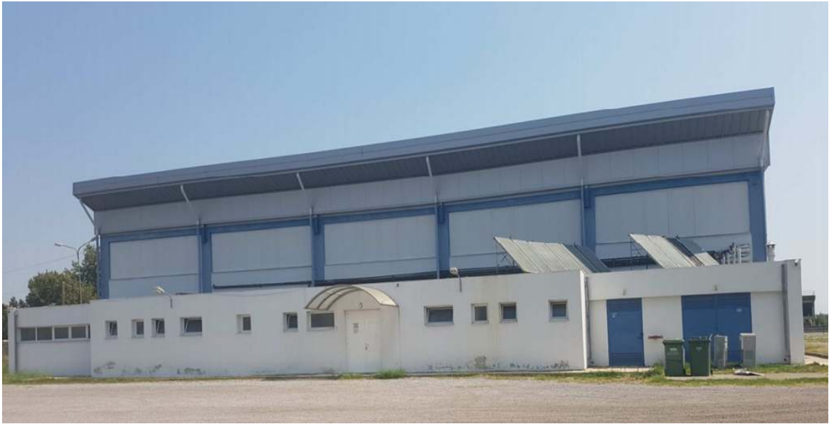
Νοτιοδυτική πλευρά κτιρίου - είσοδος στον χώρο των αποδυτηρίων
