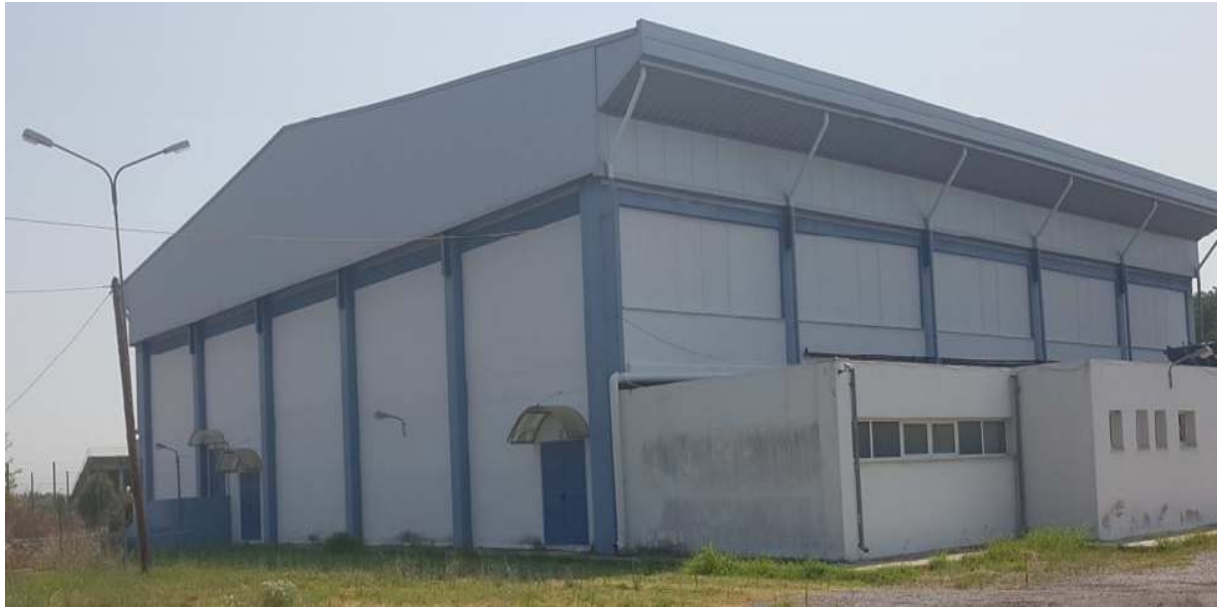
Βορειοδυτική πλευρά κτιρίου
